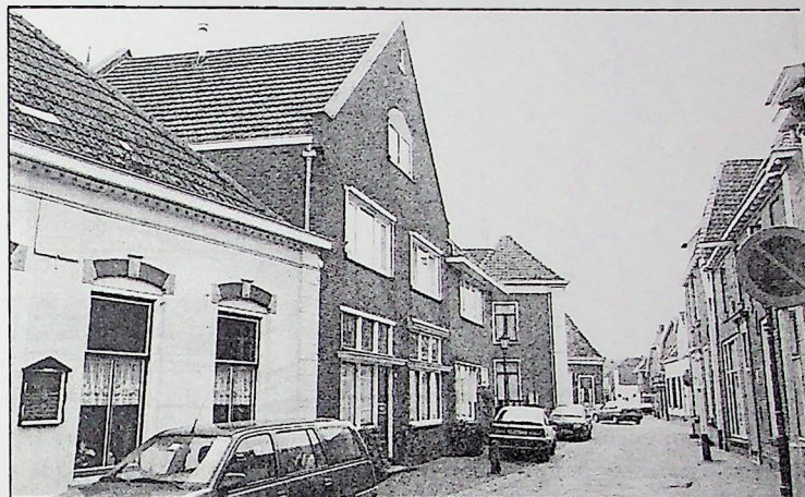
♦ Het pand aan de Landstraat 5 in Bredevoort, waar voorheen de bakkerszaak van Te Boveldt was. (Foto Ron Nagtzaam)
